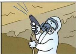
吹付けアスベスト等の層を残したまま、薬剤等を含浸したり、遮膜材を散布し、吹付けアスベスト等を固定することで飛散を防止する工法。除去工法より安価ですが、建物の取壊し時には、除去工法が必要になります。
