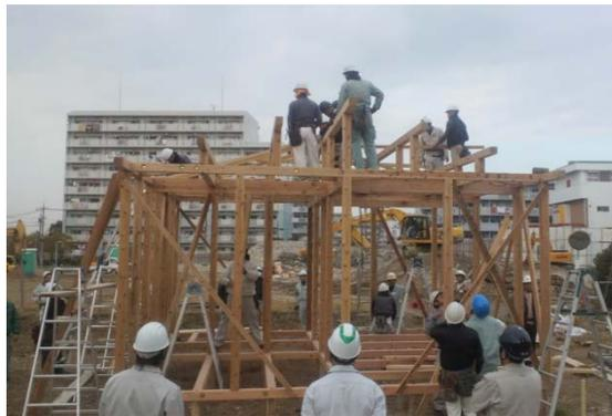
組合が所属する（社）愛知県建設団体連合会は、（社）全国木造建設事業協会を通じ、愛知県と「災害時における応急仮設住宅の建設に関する協定」を締結しています。これは、大規模災害時に、在来軸組工法による木造の仮設住宅を建設するというものです。今回の実習は災害時における施工体制の整備等を目的とし、国土交通省の補助を受けて実施されました。
